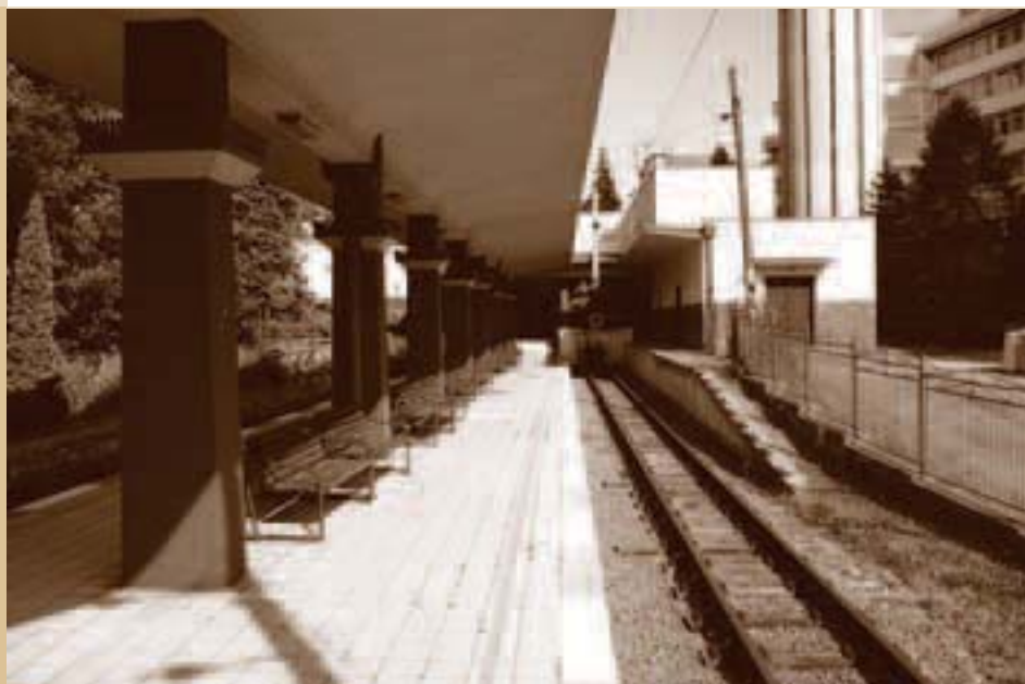
Železničná stanica Trenčianske Teplice - pohľad od nástupištia.
