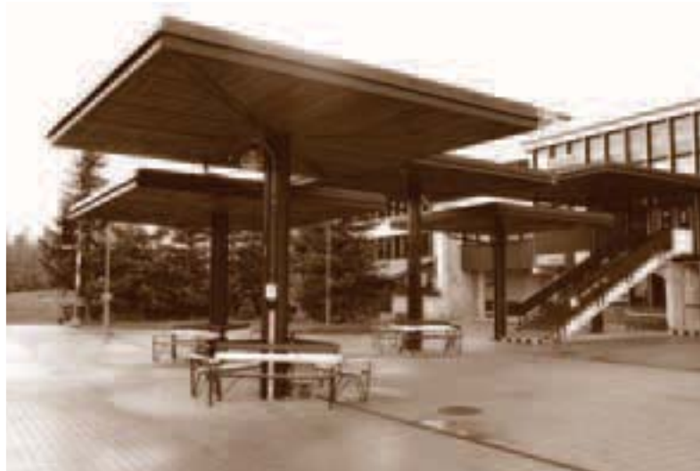
Železničná stanica Štrbske Pleso.
