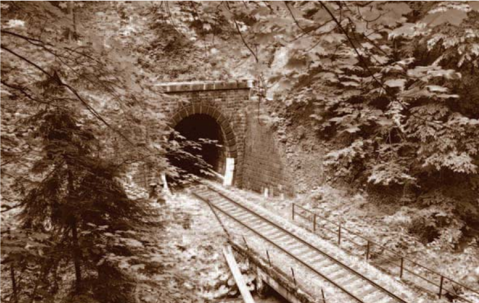
Dve umelé stavby, tunel a most, na trati SNP medzi Banskou Bystricou a Hornou Štubňou.
