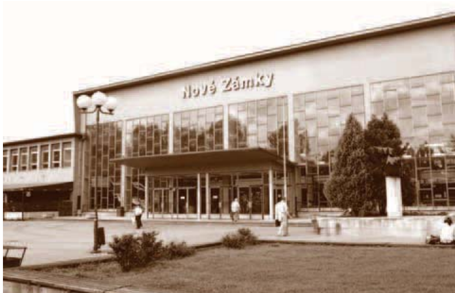
Pohľad na novozámockú stanicu od mesta.
