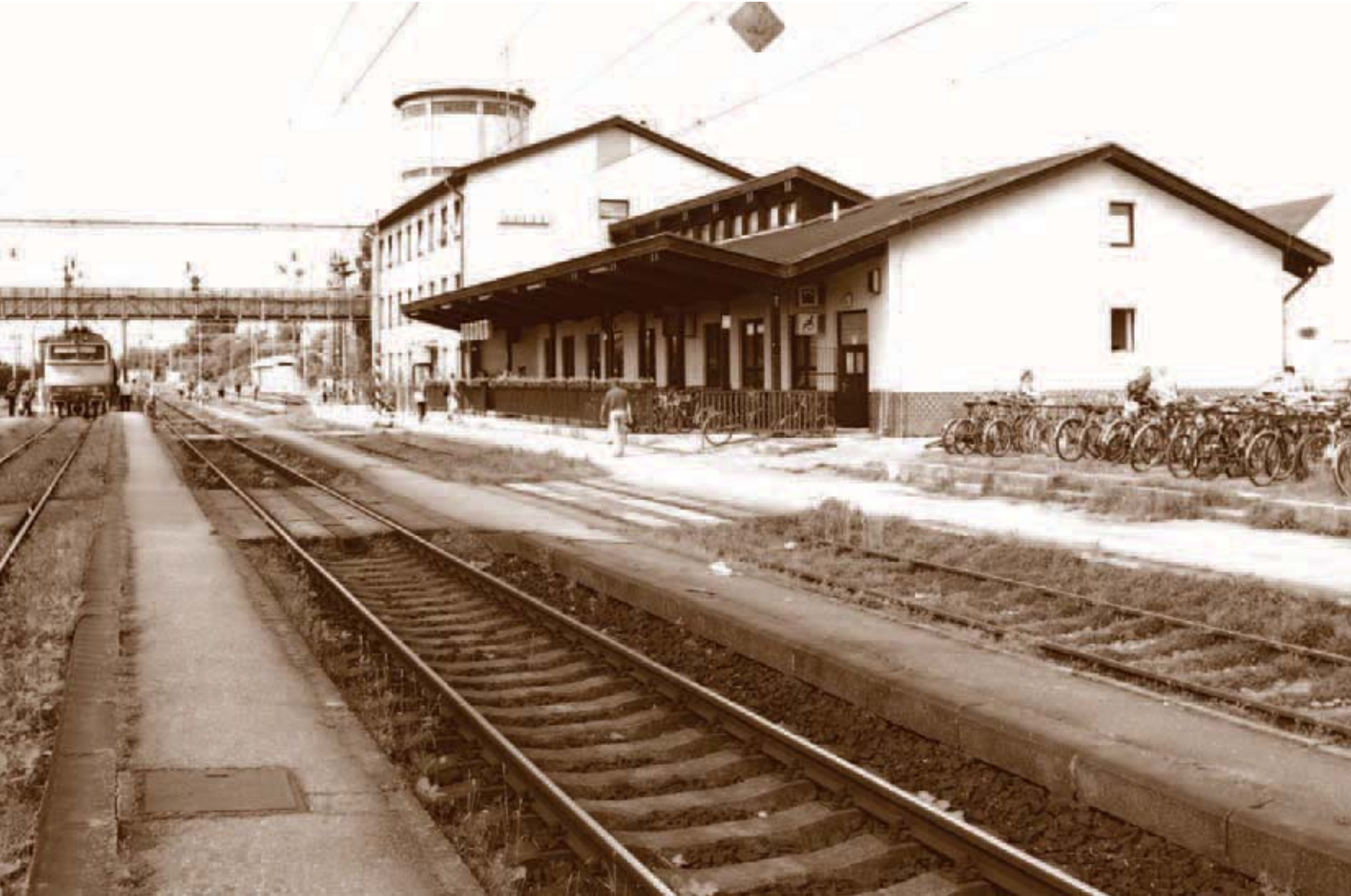
Železničná stanica Šurany je významnou križovatkou na juhozápadnom Slovensku.
