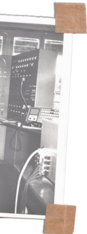
Staničné reléové zabezpečovacie zariadenie
