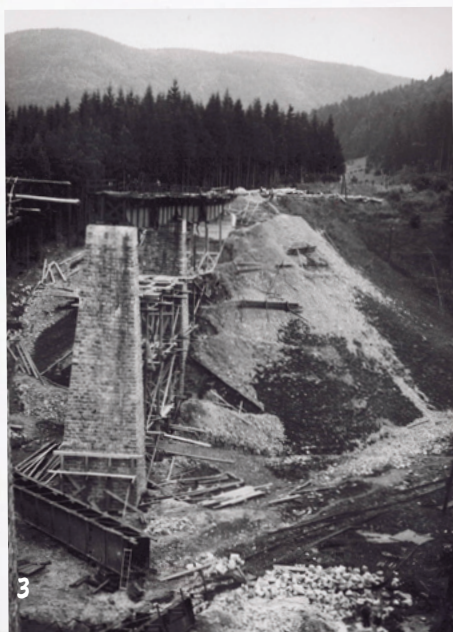
3 a 4: Viadukt „Čierna voda“, km 35,024 trati Banská Bystrica — Dol. Štubňa odb.
