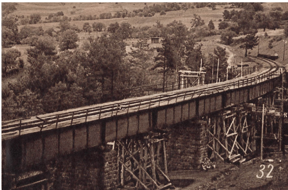
Obnova vojnou zničeného viaduktu.
