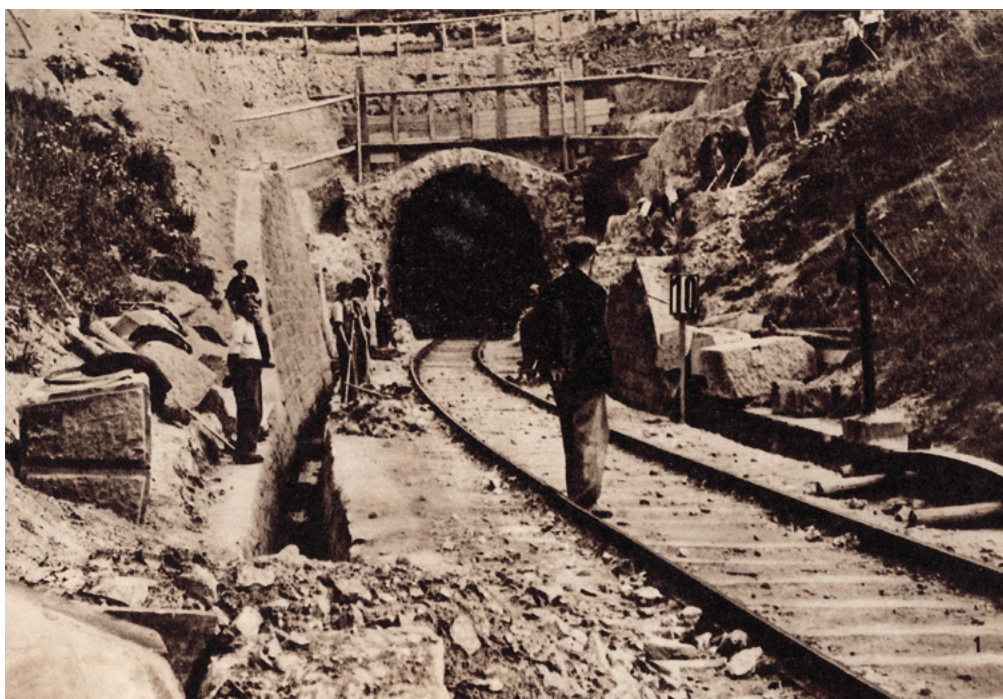
Poškodený tunel pri Hornej Štubni.
