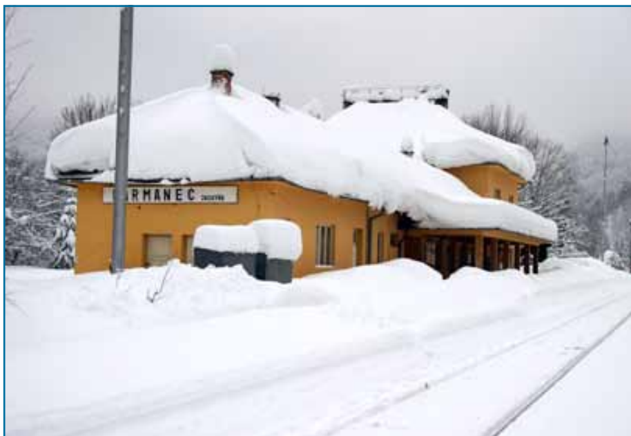
Zimná bohatá nádielka každoročne odreže železničnú stanicu Harmanec jaskyňa od okolitého sveta. Osobné vlaky v nej nestoja a k budove vedie len strmá prístupová cestička, zasypaná snehom.
