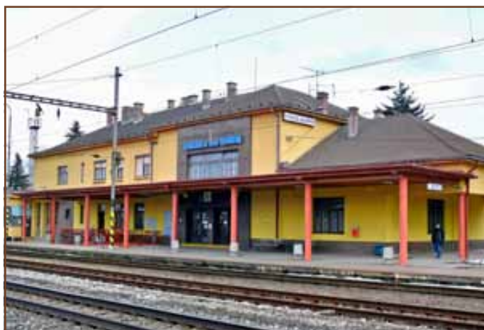
V Dubnici nad Váhom sa stavebné činnosti naplno rozbehnú od 22. februára.
