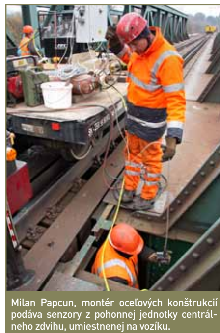
Až po nadvihnutí mostov sa mohli valce ložísk nastaviť do správnej polohy.
