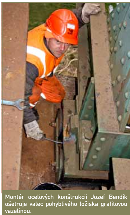
Až po nadvihnutí mostov sa mohli valce ložísk nastaviť do správnej polohy.
