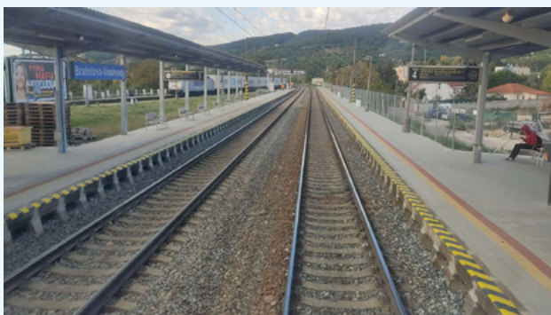
OR TT: Oprava nástupišť na zastávke Bratislava-Vinohrady
