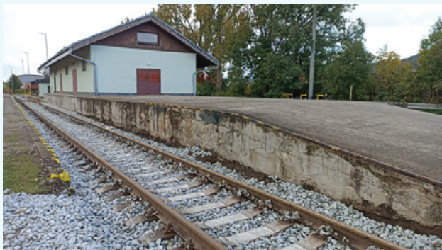
OR ZA: ŽST Trstená koľaj číslo 4 po rekonštrukcii
