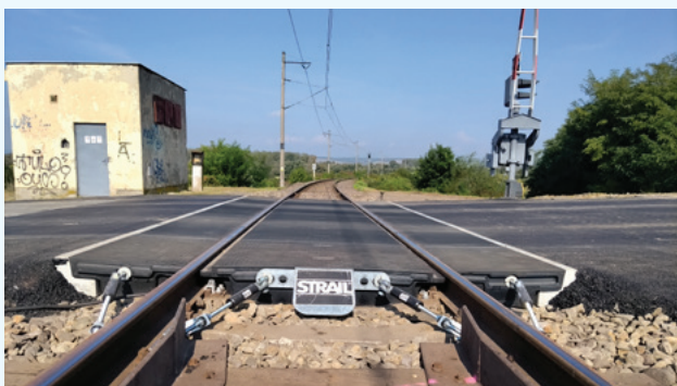
OR KE: Oprava priecestia v km 76,225 v úseku Výh. Slančík ŠRT — Výh. Hornád ŠRT
