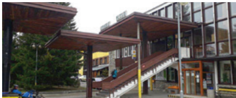
Prístrešok nad schodiskom spevnený oceľovou podperou.
