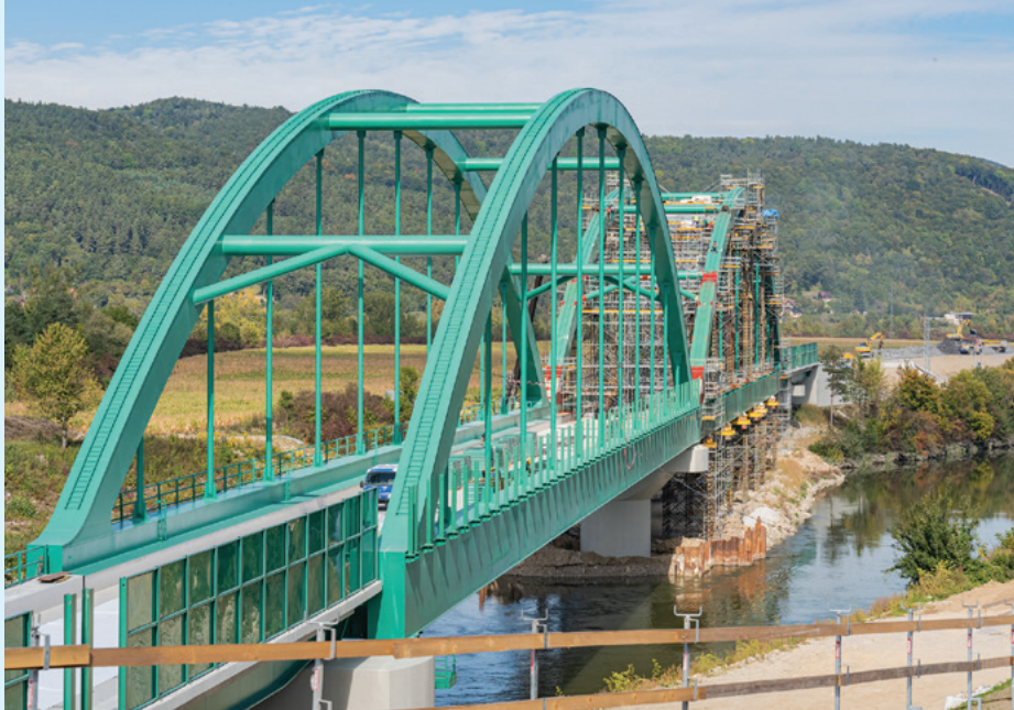
Pohľad na most vcelku od Nimnice
