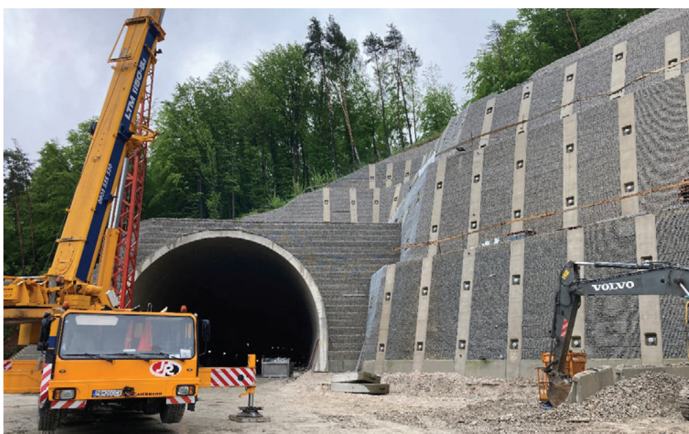
Tunel Milochovej, západný portál, montáž, kotvenie a zasypávanie gabiónových obkladov
