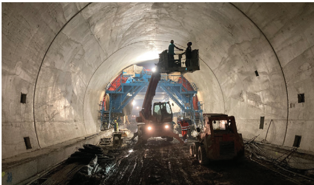
Tunel Milochovej, Betónáž hornej klenby
