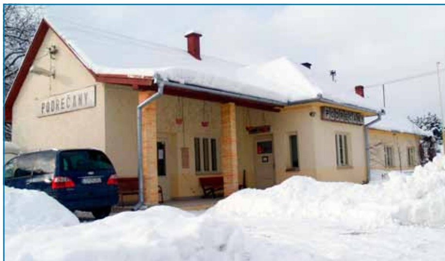
Výhybňa Podrečany je jedným z miest, kde sa železničiarri začínajú báť o svoju bezpečnosť.
