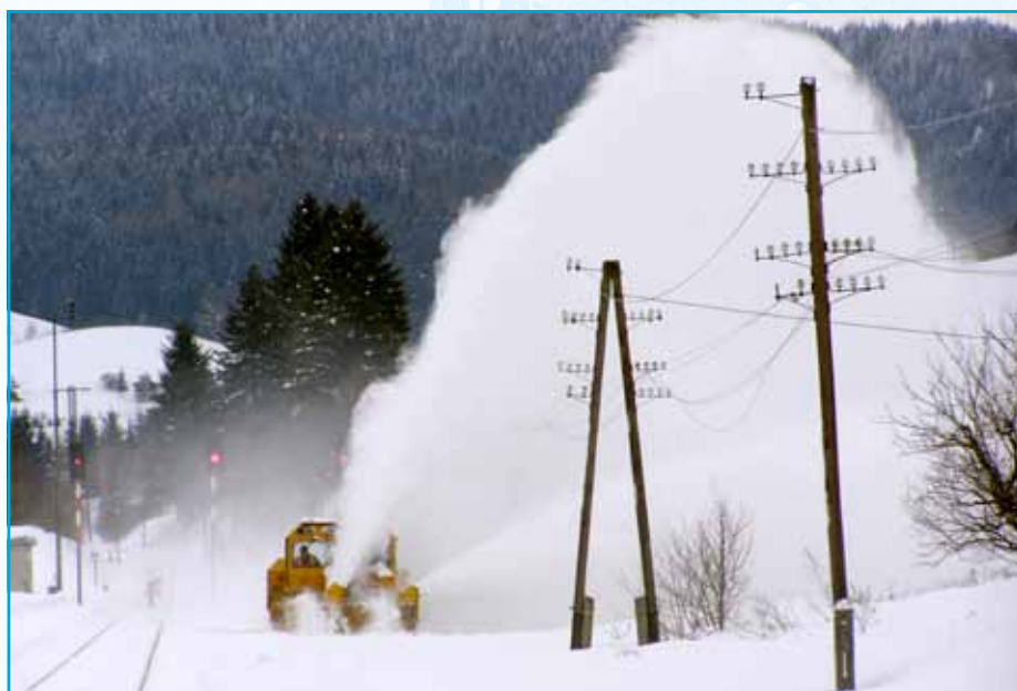
Na trati v okolí Telgártu je práca frézy takmer dennou súčasťou.
