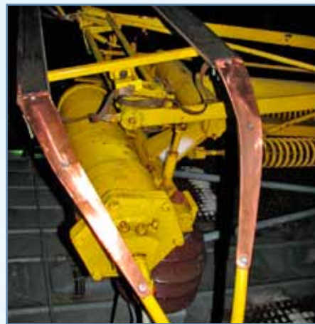
Nové ližiny sú namontované na MVTV 02-17 (SMSÚ EE TV Košice, OTV Košice). Ďalšie sú namontované na MVTV 02-20 (SMSÚ EE TV Poprad, OTV Poprad) a MVTV 03-02 17 (SMSÚ EE TV Trebišov, OTV Trebišov ŠRT).
