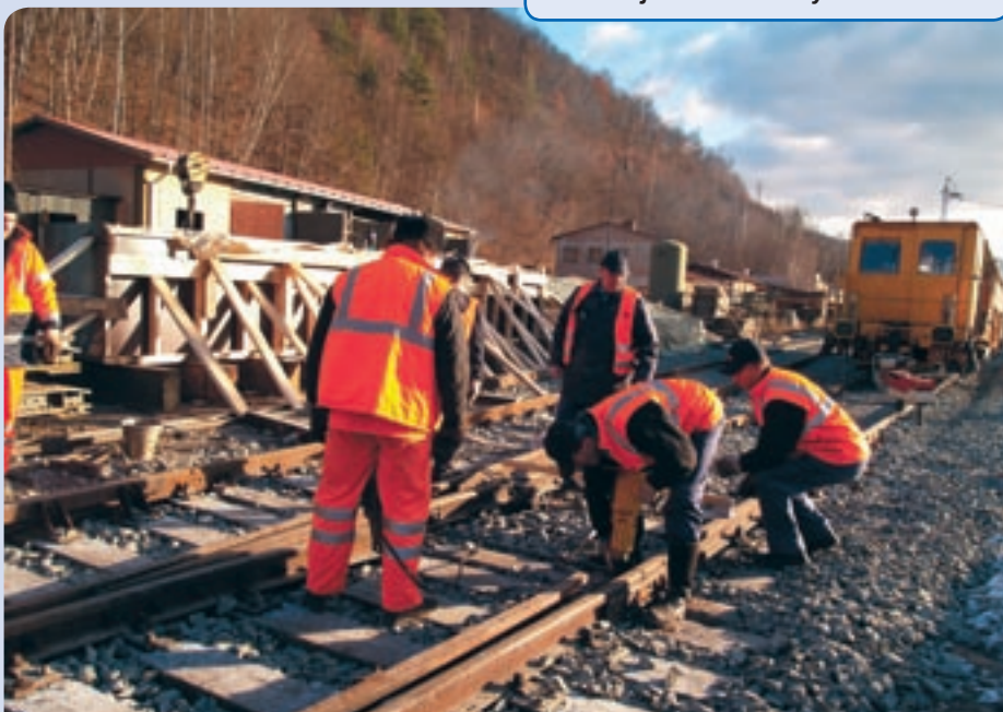
Pri komplexnej rekonštrukcii vlečky v stredu Mostného obvodu v Margecanoch pomáhali i traťováci z Margecian.
