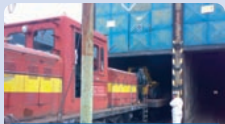
Ukončenie rekonštrukčných prác na rozmrazovacom tuneli v objekte Železničnej stanice Čierna nad Tisou je naplánované do konca tohto roku.
