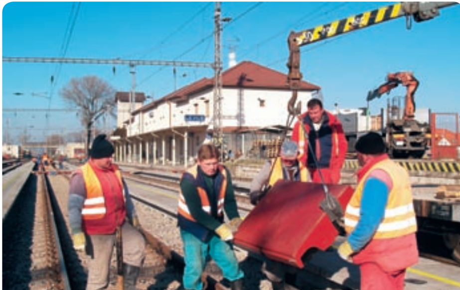
Súčasťou rekonštrukcie perónov v Železničnej stanici Levica, bolo aj uloženie gumokovových prechodov medzi jednotlivými koľajami.
