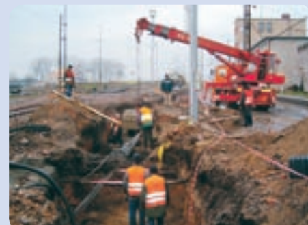
Výkopové práce pre neskoršie uloženie rozvodov do sácht sa robia aj počas nepriaznivého počasia.
