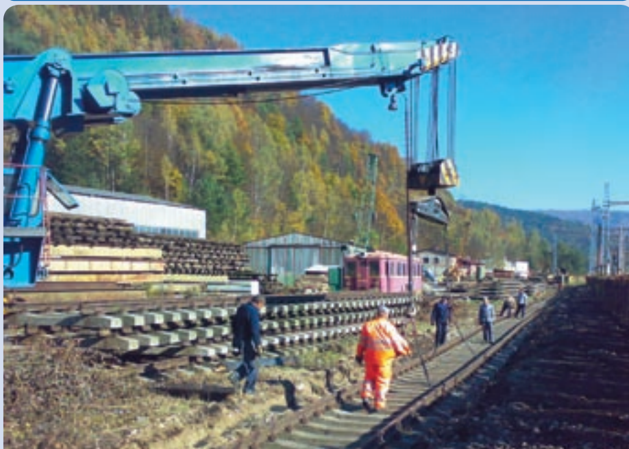
Trhacie práce a pokládku regenerovaných koľajových polí typu S49 na 50 ročnej vlečke v Margecanoch zabezpečili mostári vlastným koľajovým žeriovom EDK 750.
