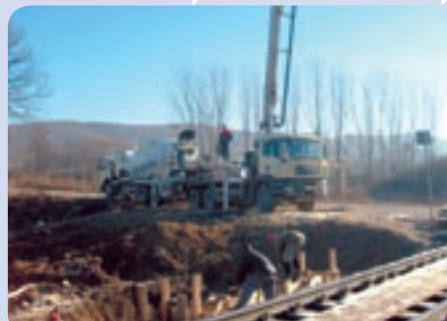
Práce na betonáži novovybudovaného priepustu na trati Košice – Žilina pri nesamostatnej Železničnej stanici Kostofany nad Hornádom.
