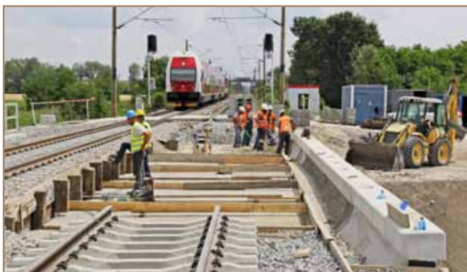
Rekonštrukcia mosta nezastavila železničnú dopravu, vlaky jazdili po jednej kolaji.
