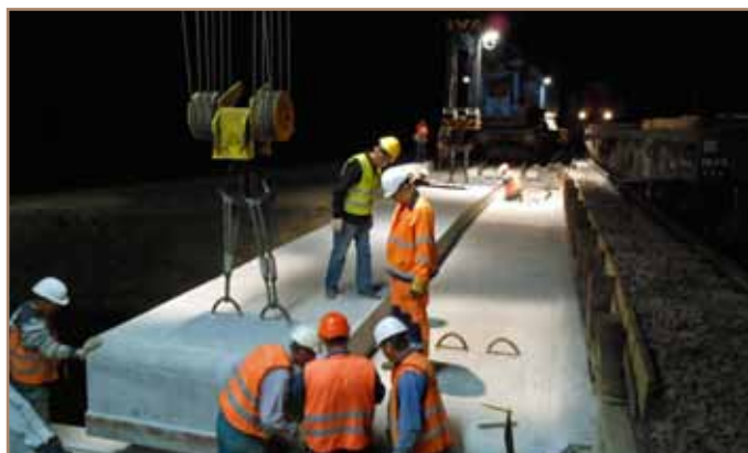
Prefabrikáty nosnej dosky mosta sa ukladali v nočných výlukách.
