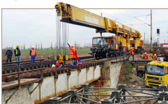
Práce začali v marci demontážou starej ocelevej konštrukcie.
