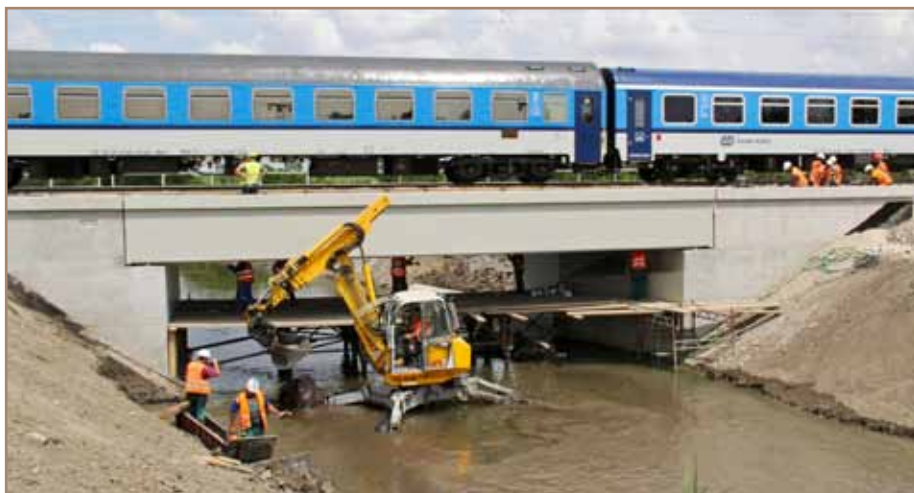
Pracovalo sa nielen na moste, ale úpravami prešlo aj koryto toku.
