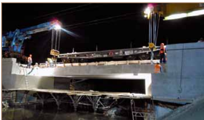
Železobetónové segmenty, vážiace až 80 ton, ukladali na opory kolajové žeriavy.
