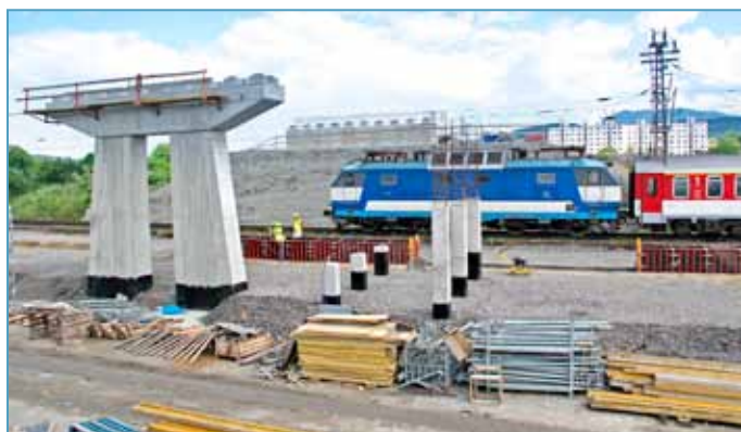
Na konci budúcej zastávky vzniká nadjazd. Nahradí súčasné úrovňové priecestie a posluží aj cestujúcim ako prístupová komunikácia k nástupištiam.
