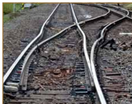
Rozbité podvaly, popraskané koľajnice, poškodené zabezpečovacie zariadenie a zdeformované výhybky. Takáto spúšť zostávala za vykoľajeným vozňom so železnou rudou.
