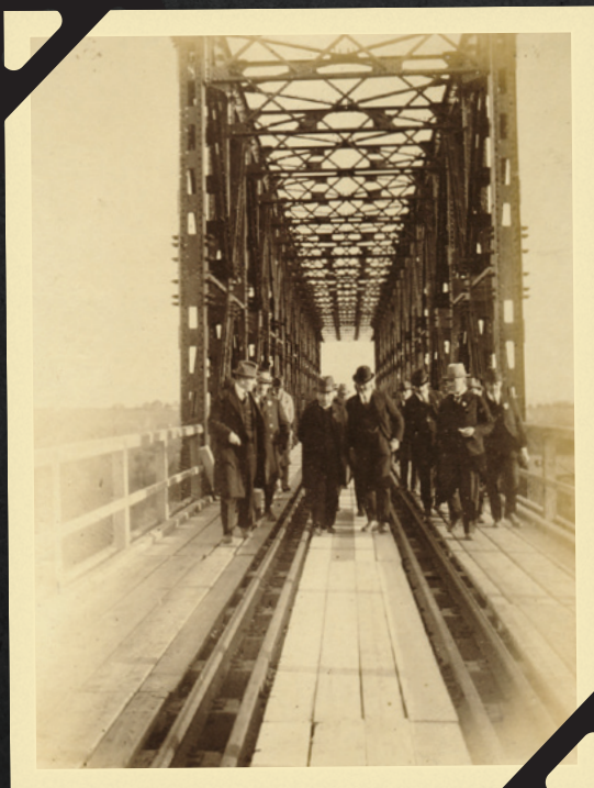
Prehliadka konštrukcie mosta cez Laborec
