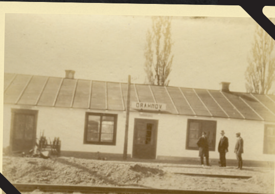
Výhybňa Drahičov staničná budova
