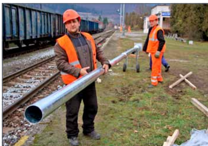
Napriek svojej hmotnosti je prenos stožiara na transportnom vozíku jednoduchý.
