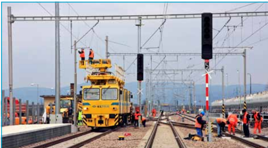
Modernizácia zmenila dĺžku koľají aj tvar koľajiska. Na stavebných prácach bolo do 30. novembra preinvestovaných vyše 23,8 milióna eur.
