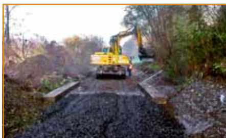
Na rekonštrukcii sa podieľali okrem dodávateľských firiem aj SMSÚ ŽTS TO Jesenské. Celkový obnovený úsek meria 4,3 km.
