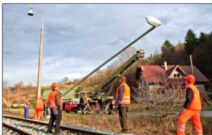
V priebehu niekoľkých minút sa stožiar dostáva z vodorovnej polohy do zvislej.
