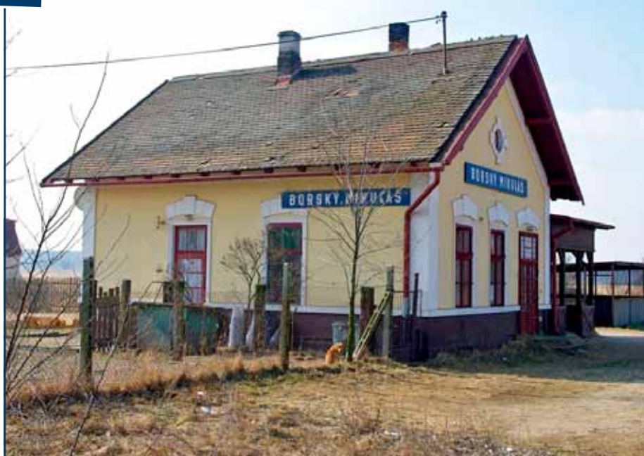
Železničná zastávka Borský Mikuláš.
