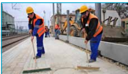
Cestujúci budú využívať 2 vybudované nástupištia spojené podchodom s výťahmi. Prvé pri staničnej budove je dlhé 278 metrov, druhé ostrovné meria 264 metrov.
