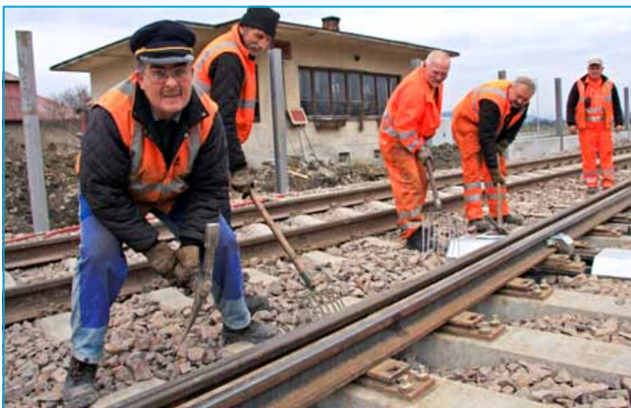
Traťoví robotníci SMSÚ ŽST TO Trenčín pracovali v Ladcoch na zazimovaní výhybiek. Toto preventívne zimné opatrenie spočíva v odhrnutí štrku spod jazyka a opornice výhybky, aby sa pri nich nevytvárali snehové záveje.
