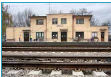
Oprava fasády staničnej budovy by mala byť ukončená do 8. mája 2013.
