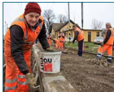
Jednotlivé prefabrikáty je potrebné ešte vzájomne cementovou maltou spojiť - zlepiť a vyšpárovať, až potom môžu spoľahlivo slúžiť verejnosti.
