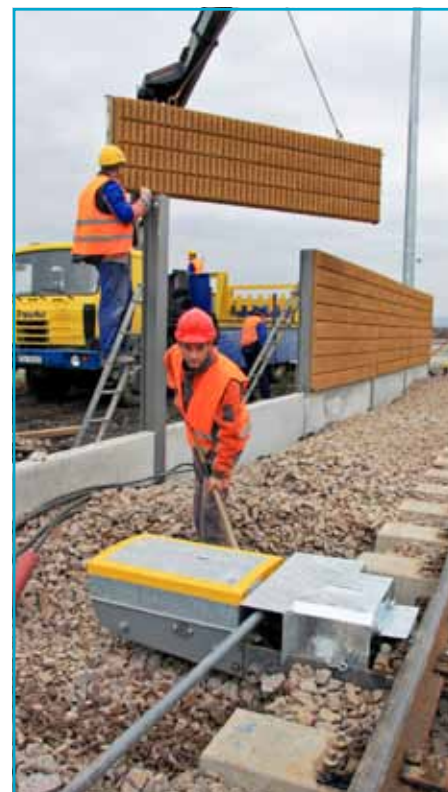
Pri modernizácii bolo položených 5342 metrov nových koľají, 16 výhybiek, vybudovalo sa 826 metrov protihlukovej steny.
