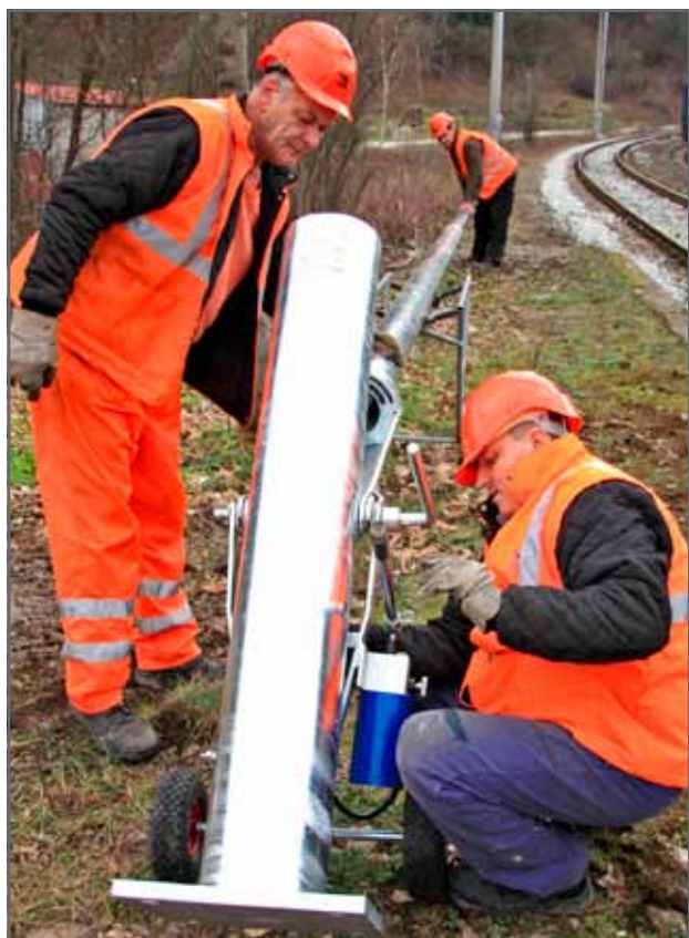
Pred montážou k betónovému základu sa musí stožiar otvoriť špeciálnou kľukou a následne jeho spodná časť sklopiť.
