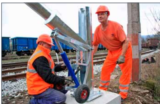
Na sklopenie a vztýčenie stožiara postačí len jeden človek s ručne ovládaným hydraulickým zariadením.
