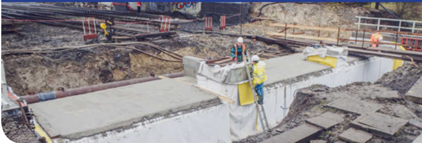
Zriadenie ochranej vrstvy izolácie na moste v km 11,807.
