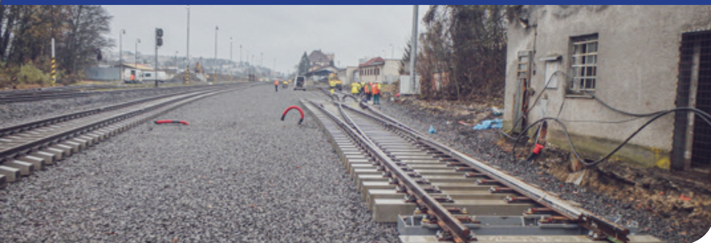
Pokládka nových výhybiek a koľaje na pripravené zhutnené štrkové lôžko.
