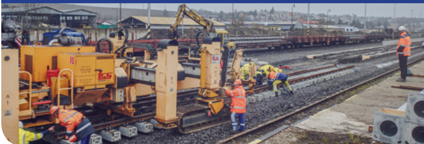
Práce v koľajisku sa vykonávajú aj za pomoci ťažkých strojov.
