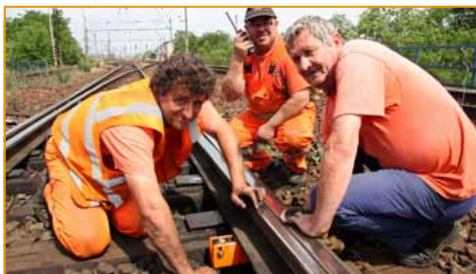
Viliam Mihál, Jozef Hamburg a Ján Filip, zámočníci koľajových konštrukcií z SMSÚ ŽTS TO Bratislava sa s nastavením valčkov na starých výhybkách v ŽST Devínska Nová Ves natrápili podobne, ako mnohí ich kolegovia inde na Slovensku.
