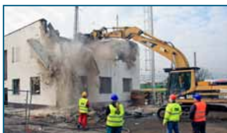
S demolíciou budovy sa začalo 23. októbra....
