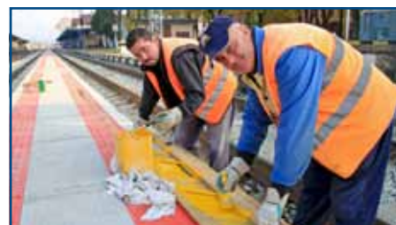
Súčasťou nového nástupištia sú aj výstražné šikmé pruhy.
