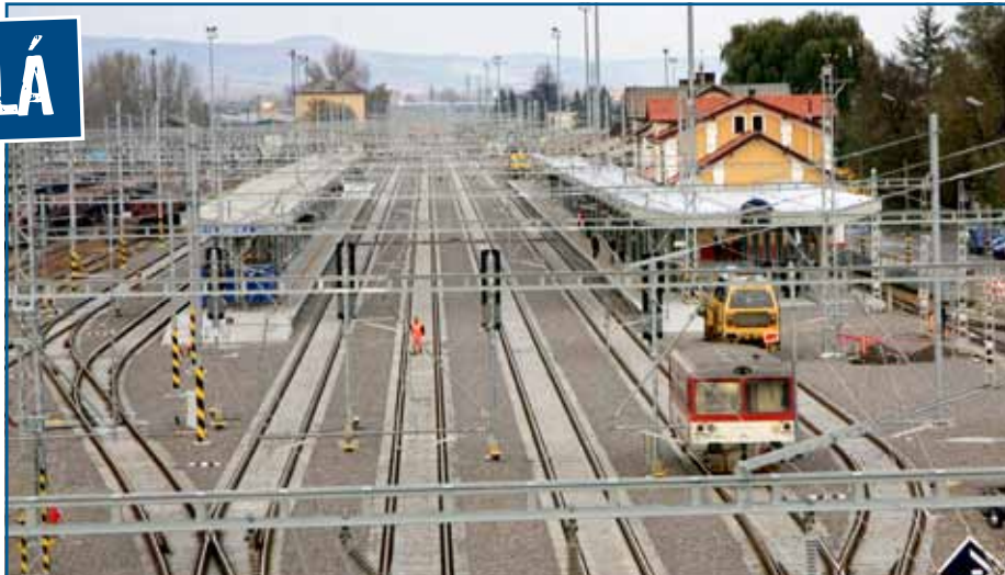
Rýchlosť výstavby svedčí o tom, že všetko správne klapalo. V stanici bolo položených 5600 metrov koľajového zvršku typu UIC a 32 výhybiek, 31-tisíc kubíkov štrku navážalo 65 vlakov.
