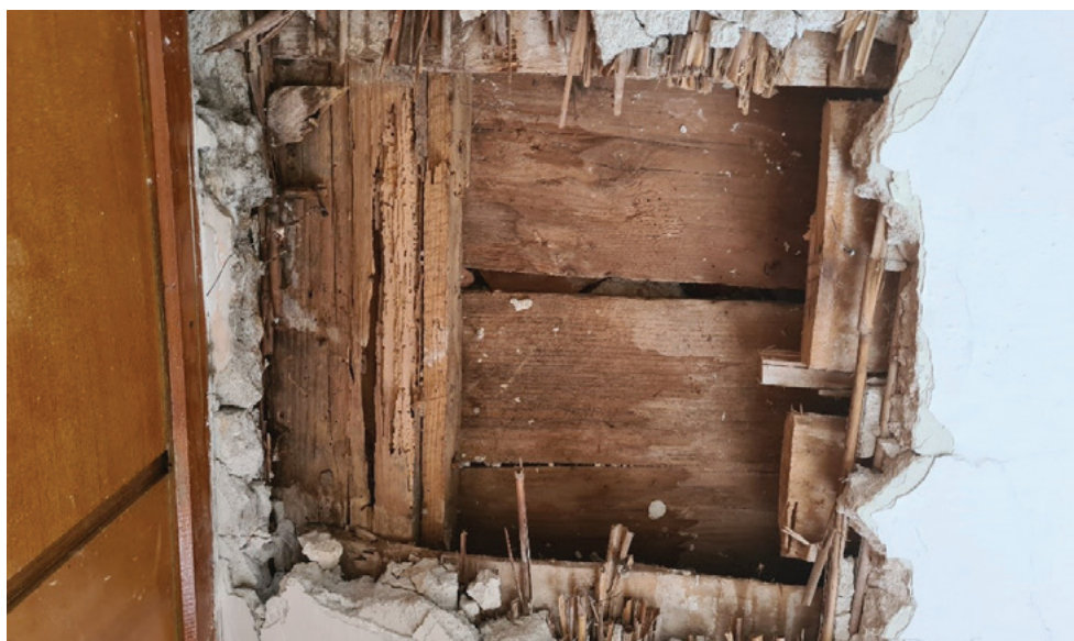
Pomocné hranoly, nosný hranol zo spodnej strany — napadnutie červotočom.
