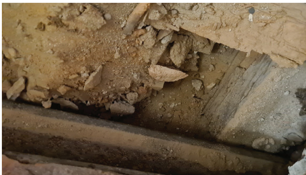
Zachovaný drevený hranol v styku s nosnou stenou.
