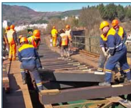
Každá z 296 mostníc mala presne určené miesto vyliae polyuretánom. Požadované prevýšenie koľaje sa docielilo priskrutkovaním klinových podloží k mostniciam.
