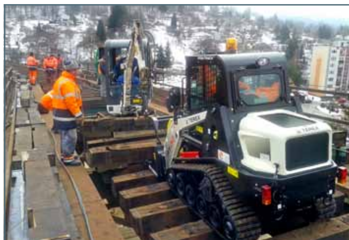
Počas demontáže starých mostníc s pásovými mechanizmami prekvapila mostárov snehová nádielka.
