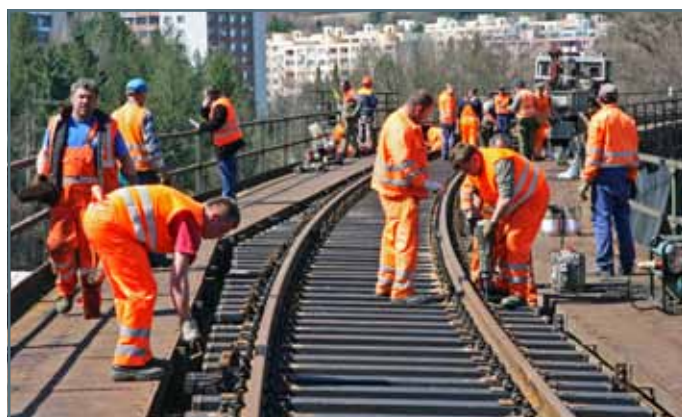
Zamestnanci SMSÚ ŽTS TO Topoľčany vylepšili počas výluky technický stav trate nielen na viadukte, ale aj medzi Prievidzou a Chrenovcom.
