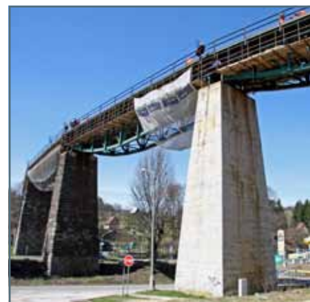
Plné lešenie obopínalo v apríli oceľovú konštrukciu viaduktu kvôli zaisteniu bezpečnosti práce zamestnancov ŽSR, ako aj osôb a vozidiel pohybujúcich sa pod mostom.
