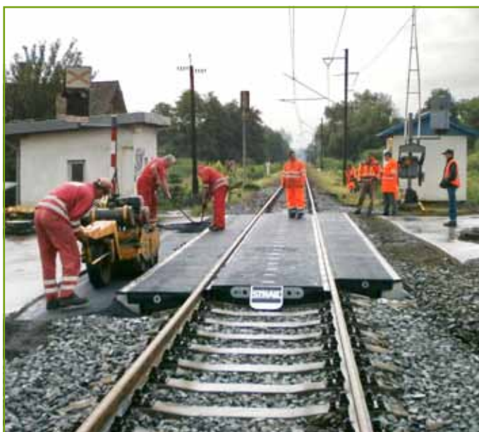
Prejazd cez celogumovú priecestnú konštrukciu STRAIL v Haniske pri Prešove je pre vodičov cestných vozidiel omnoho hladší a komfortnejší.
