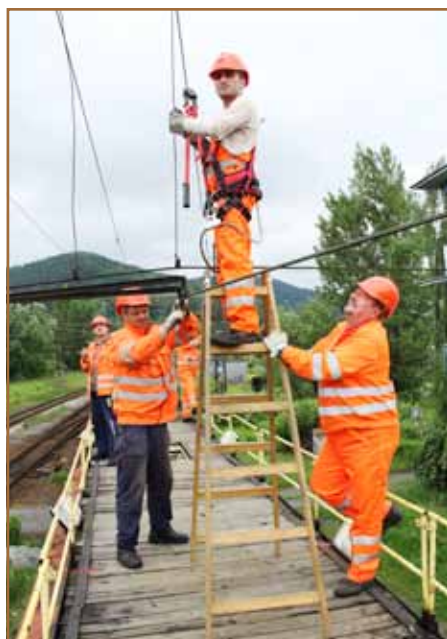
Zamestnanci SMSÚ EE TV Žilina demontujú nepoužívané trolejové vedenie z vlaku trakčného vedenia.
