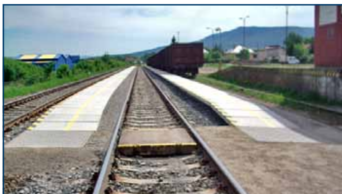
Nové nástupištia vyhovujú predpisom a normám, ale čo je najdôležitejšie, uľahčili výstup a nástup cestujúcich do vlakov.
