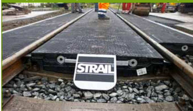
Prejazd cez celogumovú priecestnú konštrukciu STRAIL v Haniske pri Prešove je pre vodičov cestných vozidiel omnoho hladší a komfortnejší.
