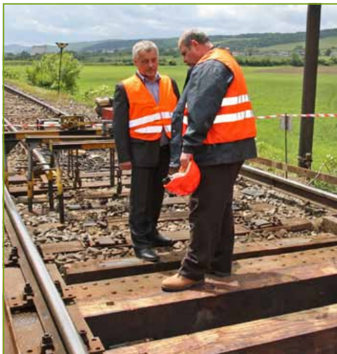
Na moste v Kendiciach sme počas výluky zastihli aj zľava: Ing. Jána Nastišina, riaditeľa OR Košice a Ing. Jána Semana, riaditeľa košického mostného obvodu.
