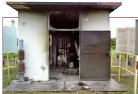
Prírodný atmosférický úkaz poškodil dekompenzačné meniče v domčeku, vedľa stojaci transformátor a prístrojový transformátor napätia v rozvodni 25 kV.
