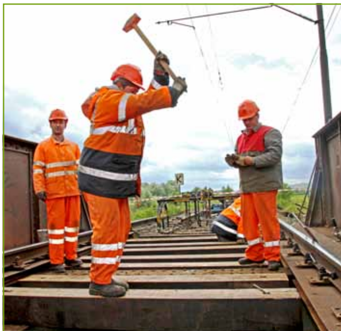
Viete, akú činnosť vykonáva tento silný chlap, ktorého sme na moste v Kendiciach nazvali Herkulom? Obrovským kladivom udrie po mostnici, akoby skúšal koľko vydrží... Ide však o otláčenie mostnice, ktoré zabezpečí silným nárazom a v miestach „otlakov“ sa vyznačia miesta na uloženie. Naším Herkulom bol Alexander Schutz.
