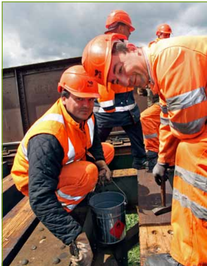
Ťažko nahovoriť chlapov na zapózovanie na moste, kde je každý sústredený na svoju činnosť. Podarilo sa nám to pri ošetrovaní a nátere uložených plôch pásnice, ktorú vykonávali zľava: Jaroslav Baran a Martin Mesarč. V pozadí, v strede je vedúci prác Peter Malinovský.
