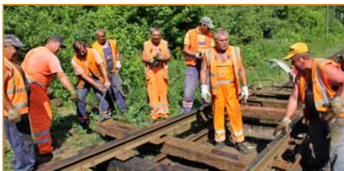
Traťoví robotníci SMSÚ ŽTS TO Jesenské vymenili až 227 nahnitých podvalov.
