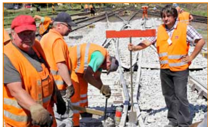
Mgr. Rastislav Šotkovský (vpravo) manuálne pomocou zámerných krížov vytyčuje výškovú polohu výhybky, aby chlapí vedeli, o koľko ju ešte musia zdvihákmi nadvihnúť a podbiť.
