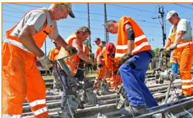
Osem chlapov manuálne podbijať križovatkovú výhybku. Škoda len, že takto museli mŕňať svoju energiu v súčasnej pretechnizovanej dobe.
