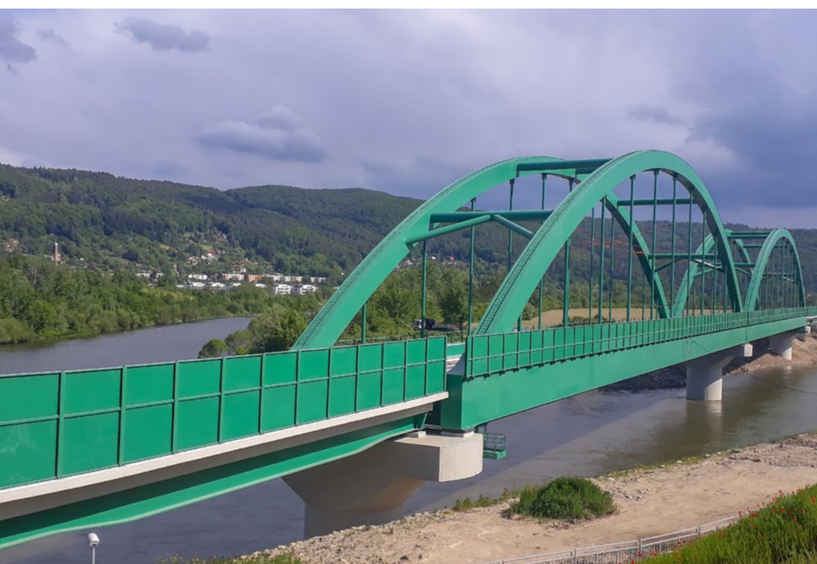
Železničný most nad Nosickým kanálom – v prvej polovici roku 2020 sa podarilo dokončiť práce na novom železničnom moste nad Nosickou priehradou, ktorá vedie železničnú trať ponad koryto Nosického kanála. Most bol dokončený v júni 2020.
