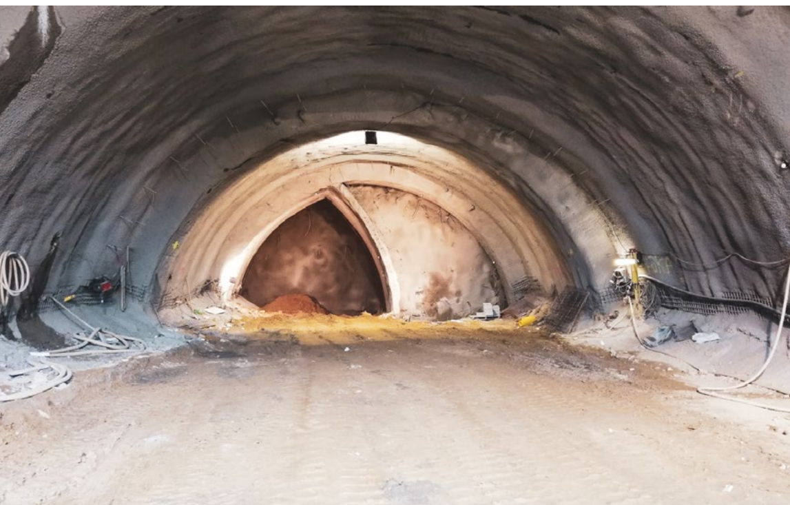
V tuneli Milochovo aktuálne prebiehajú raziace práce. Postupuje sa pri nich systémom „strop a dno“ t. j., že v tunelovej rúre sa najprv razí priestor pod budúcim stropom tunela, kde je aktuálne v kalote vyrazených viac ako 1 447 metrov.
