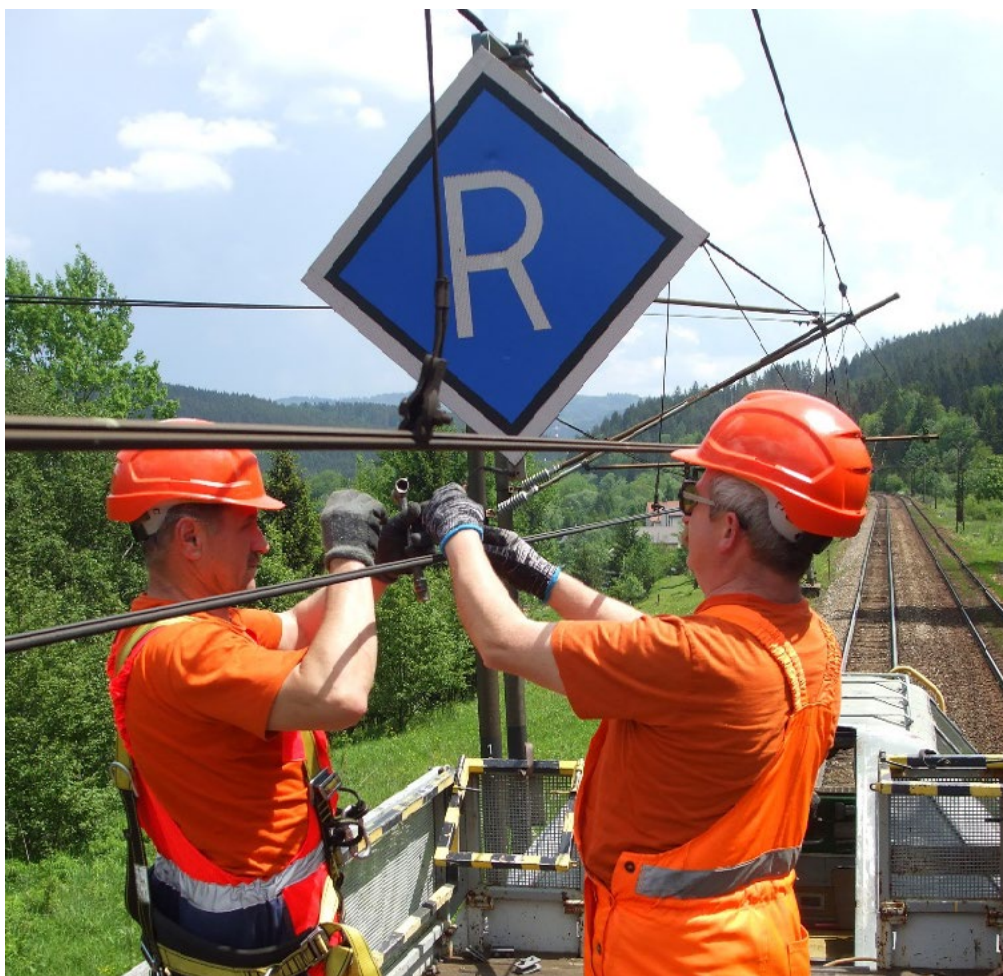
Osadzovanie návěstidla pre elektrickú prevádzku s návěstťou „Rekuperácia dovolená“ na novom mieste na štátnej hranici s Českou republikou v medzistaničnom úseku Mosty u Jablunkova – Čadca.
