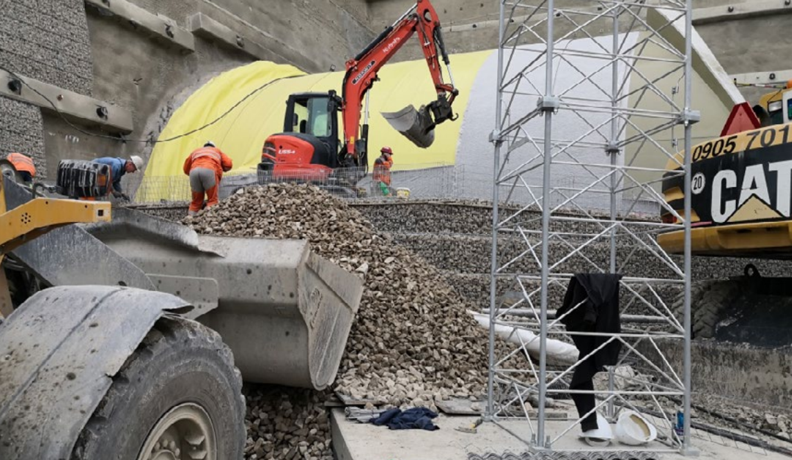
Oporný gravitačný múr – úprava hlbenej časti tunela Diel na východnom portáli.
