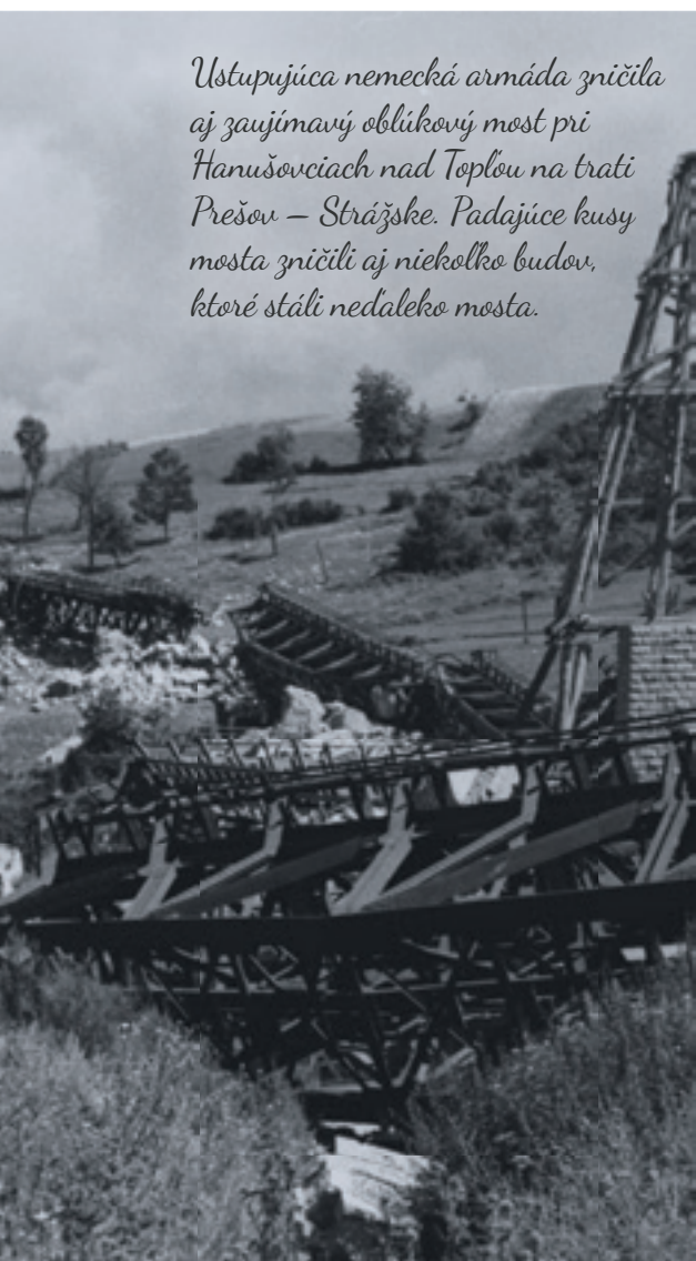
Poškodený oceľový most na neznámom mieste, pravdepodobne na niektorej horskej trati na strednom Slovensku. Ak niekto vie identifikovať miesto, napíšte nám!
