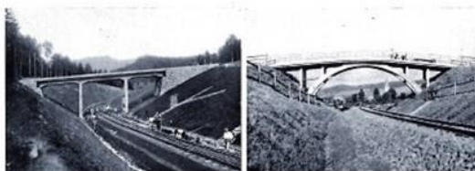
83 Rámový nadjezd ve stav. km 5037
